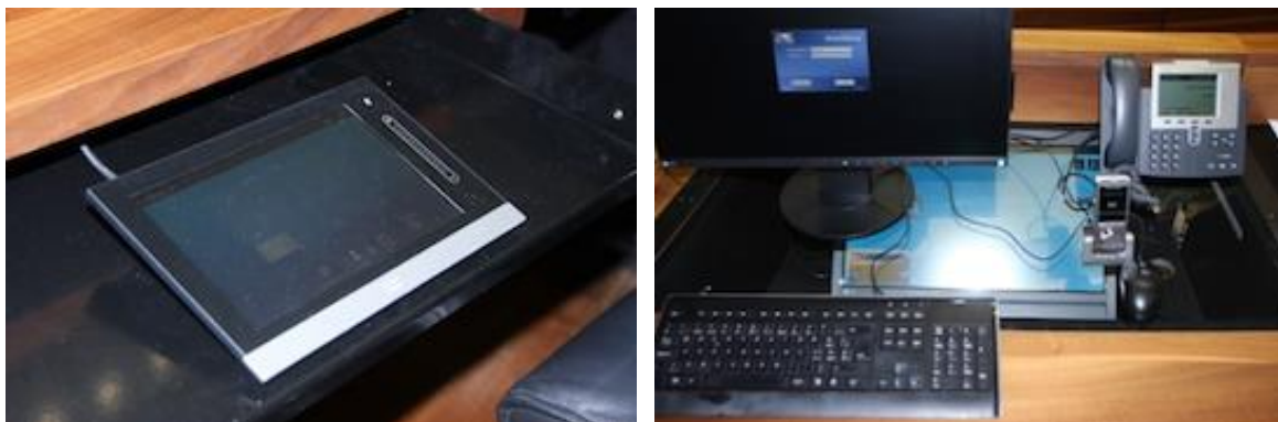
Abbildung 15: Versenkter Bildschirm zur Steuerung des Videosystems; rechts Kontrollmonitor
